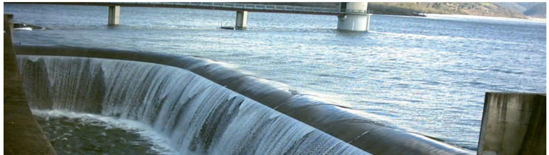
Fig. 15. Diga di Piano della Rocca: scarico di superficie in esercizio.
