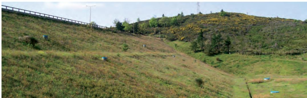
Fig. 10. Diga Fabbrica. Paramento di valle protetto da tappeto vegetale e sistema canalizzato di raccolta delle acque piovane.
