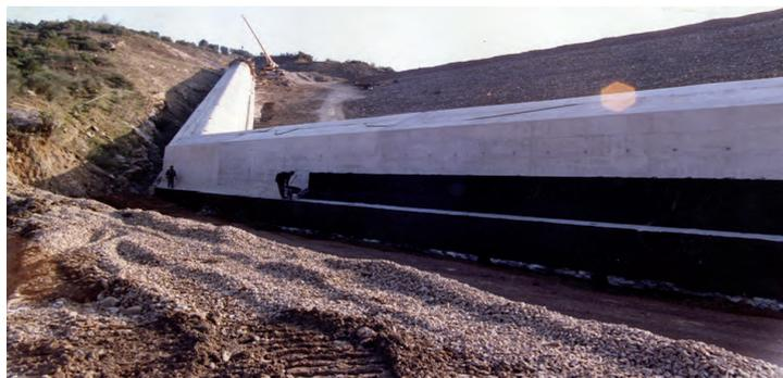
Fig. 11. Diga di Piano della Rocca. Cunicolo in fase di costruzione – fondovalle e spalla sinistra.
