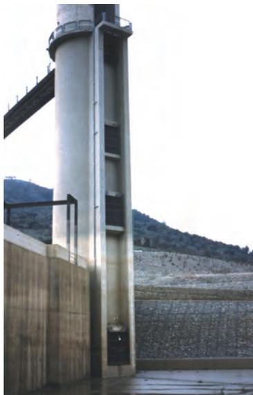
*Fig. 18. Diga di Piano della Rocca. Torre di presa a in-vaso vuoto con visibili le tre bocche di presa.*
