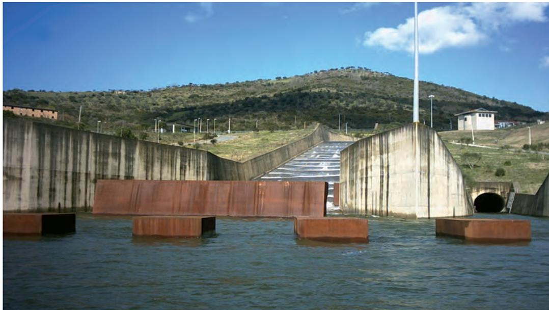
Fig. 13. Diga di Piano della Rocca. A sx scivolo dello scarico di superficie, a dx sbocco della galleria dello scarico di fondo. In primo piano vasca di dissipazione con rostri.
